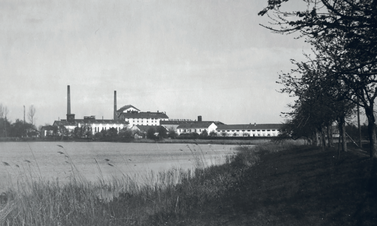
Chropyně, celkový pohled na cukrovar, založený roku 1867 Akciovou společností císařsko-královského soukromého cukrovaru v Chropyni. Archiv NTM, Sběrka cukrovarnických archiválií, III.a/42, kt. 1
