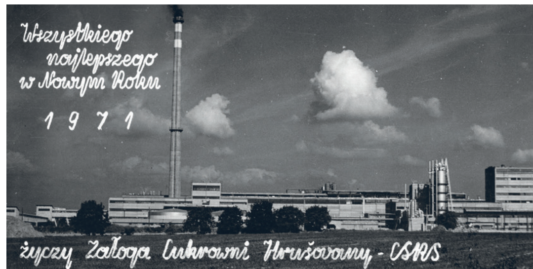
Hrušovany nad Jevišovkou, novoroční přání s fotografií nově vybudovaného cukrovaru. Sběrka Daniela Froňka
