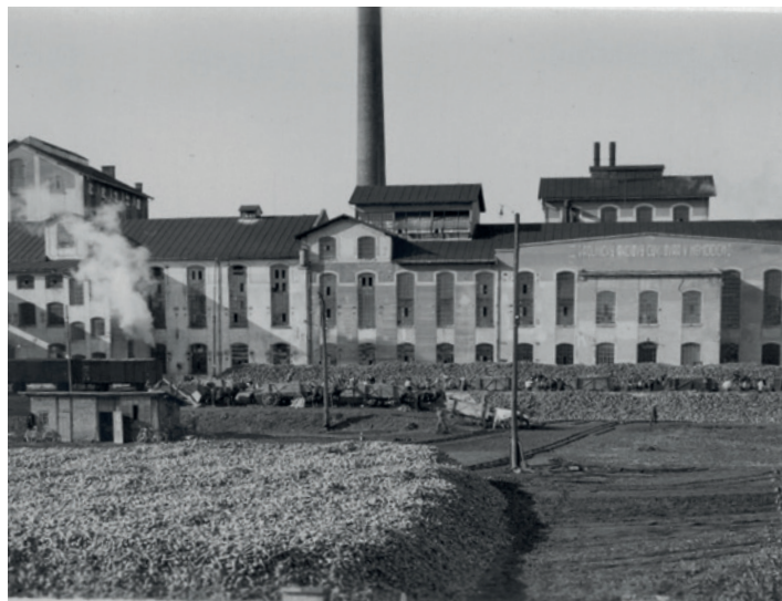
Němčice nad Hanou, tovární dvůr s řepnými splavy, stav po roce 1919. Sbíрка Daniela Froňka
