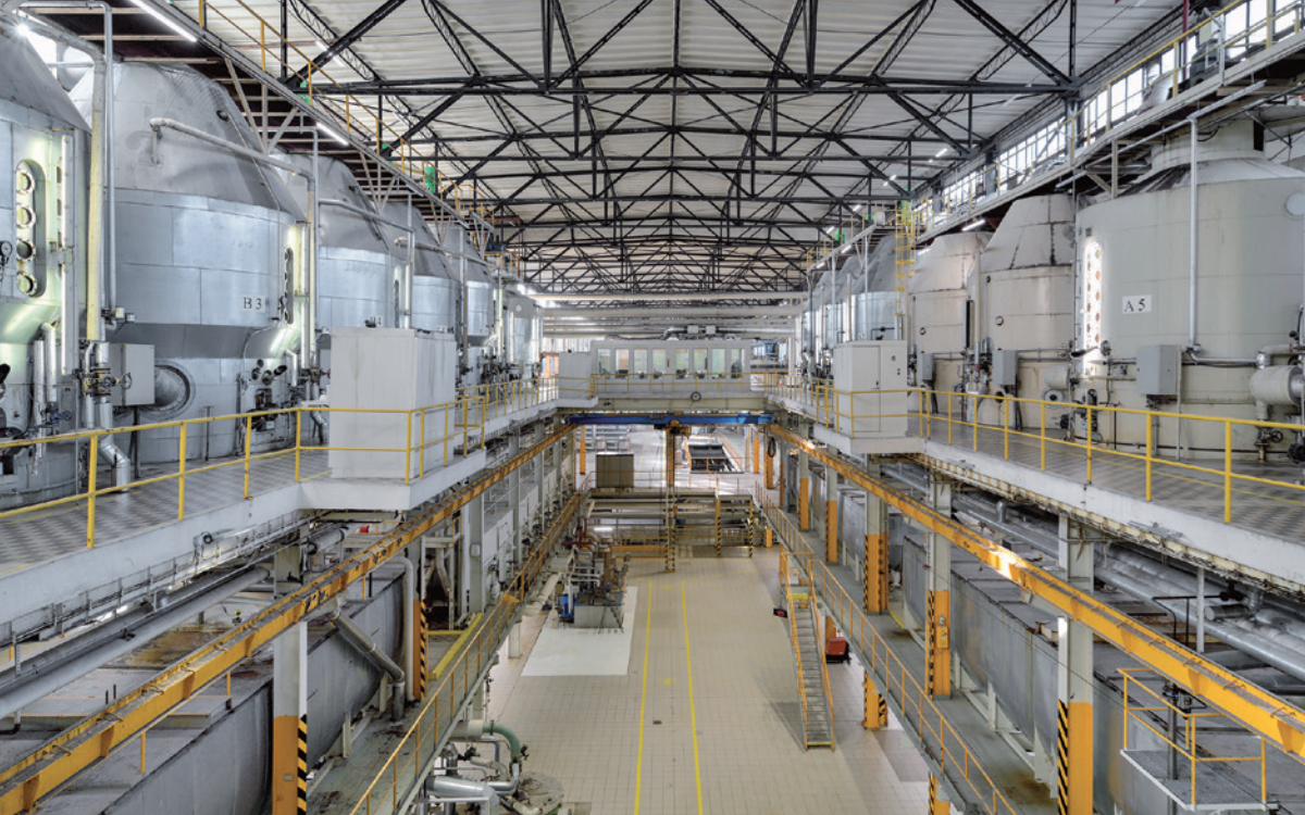
Hrušovany nad Jevišovkou, varna se zrníči (nahore), nádržemi pro dozrávání (uprostřed) a odstředivkami (dole). Foto Roman Polásek, 2023
