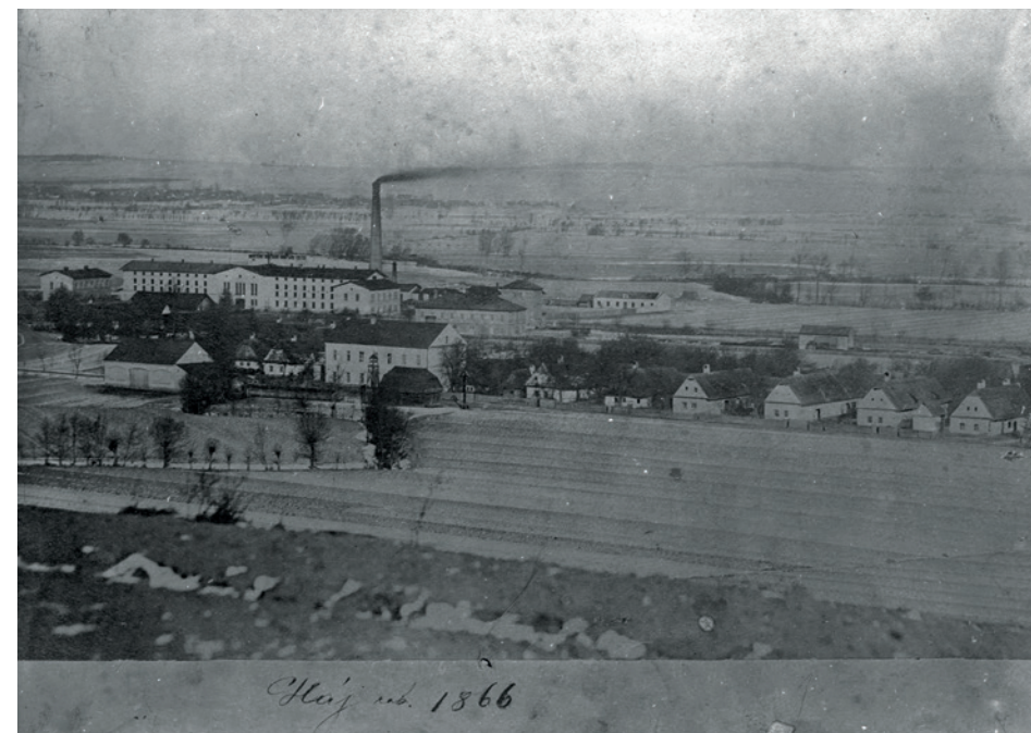
Hájí ve Slezsku, snímek z roku 1866. Průčelí cukrovaru z roku 1859 bylo orientováno k železniční trati Svinov–Opava, jež byla jako odbočné křídlo Severní dráhy císaře Ferdinanda zprovozněna v roce 1855. Z původního areálu jsou zachovány obytné objekty, které předstupovaly po stranách před výrobní budovu. Slezské zemské muzeum v Opavě, fotografické pracoviště, skleněný negativ
