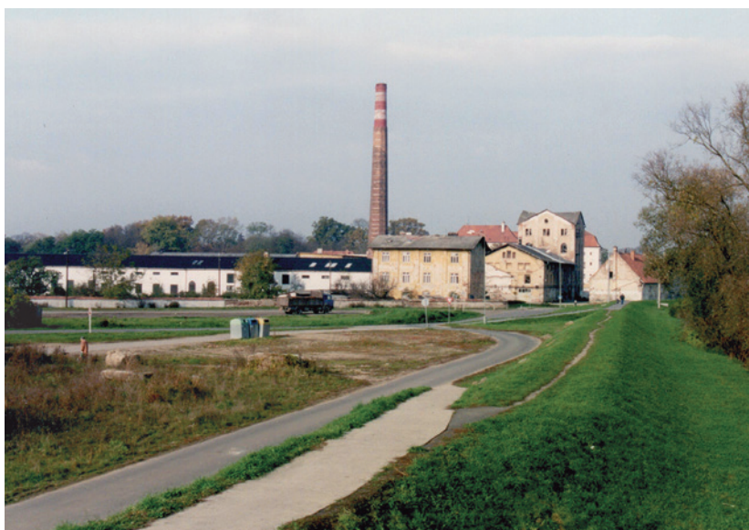
Židlochovice, areál cukrovaru od jihozápadu v době demolice budov. Foto Daniel Froněk, 2001
