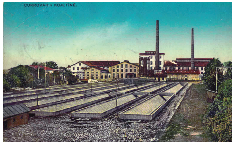
Kojetín, pohled na cukrovar přes řepné splavy, dobová pohlednice. Sbíрка Miloše Matěje
