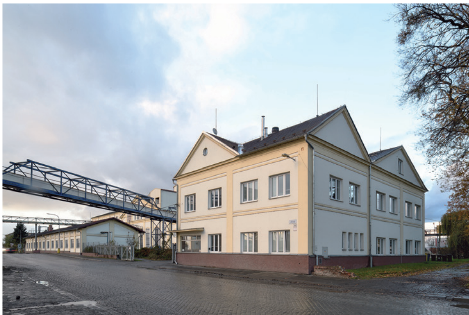
Litovel, správní budova a dílny. Foto Roman Polášek, 2023
