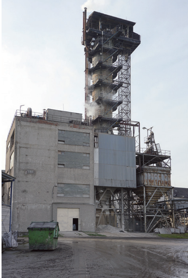
Litovel, vápenka o obsahu 120 m 3 typu Přerovské strojírny. Foto Daniel Froněk, 2019
