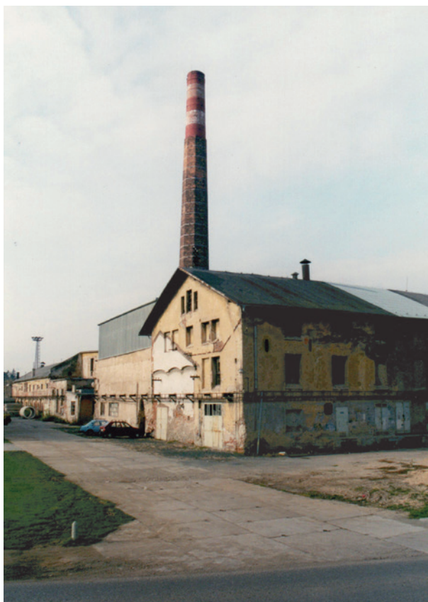
Židlochovice, kotelna cukrovaru od jihovýchodu před demolicí. Foto Daniel Froněk, 2001
