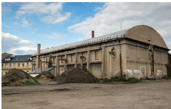
Břeclav, skladiště krystalu, pohled od východu. Foto Eva Puella, 2023
