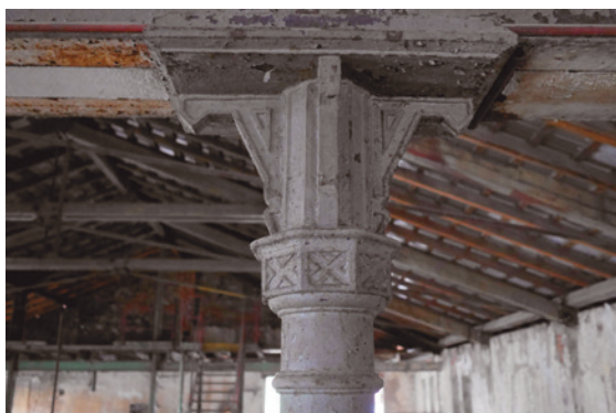
Dřevohostice, detail hlavice litinového sloupu nosné konstrukce výrobní budovy. Foto Michaela Ryšková, 2018
