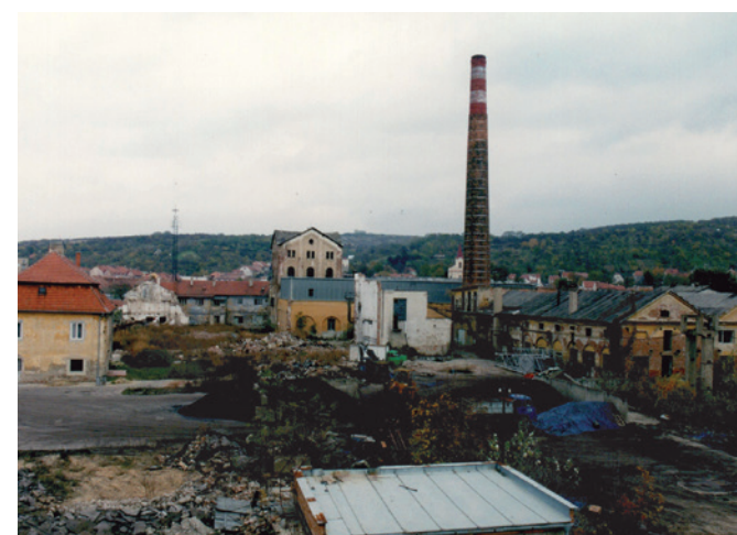
Židlochovice, torzo areálu cukrovaru od západu během demolice. Foto Daniel Froněk, 2001
