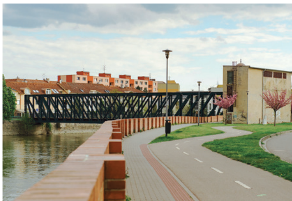
Břeclav, nýtované konstrukce mostovky cukrovarnické železniční vlečky, pohled od západu. Foto Eva Puella, 2023
