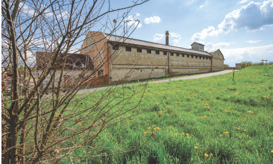
Dřevohostice, skladiště cukru, pohled od severu. Foto Eva Puella, 2023
