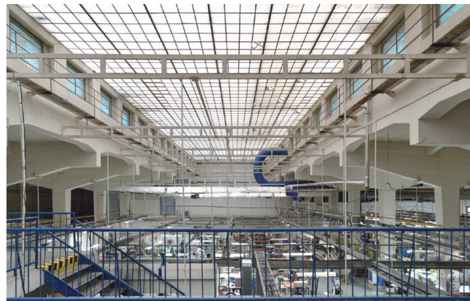
Hrušovany u Brna, budova rafinerie, nejvyšší patro pod střešním světlíkem. Foto Roman Polášek, 2023
