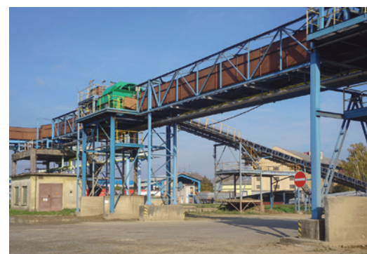
Litovel, vrchní plavící linka řepy s lapačem písku a kamení. Foto Roman Polášek, 2023
