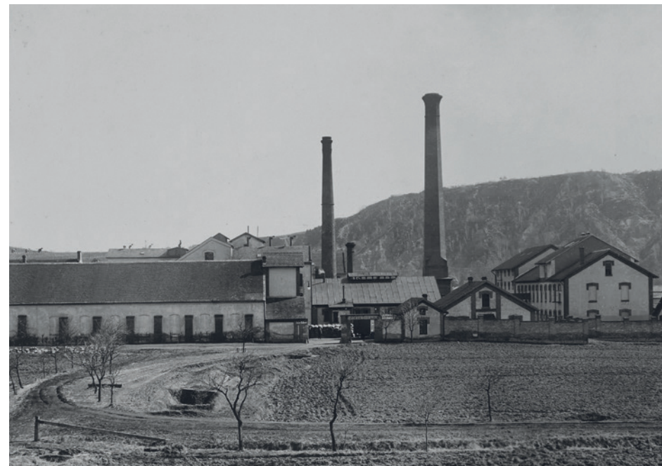
Brno, cukrovar na Starém Brně patřil ve 2. polovině 19. století k významným moravským cukrovarům. V roce 1906 vyhořel a jeho provoz již nebyl obnoven. Zbylé objekty jsou spolu s rodinným sídlem, tzv. Bauerovým zámečkem, součástí areálu brněnského výstaviště. Archiv NTM, Sběrka fotografií, album Altbrünner Zuckerfabrik 1903/4, P1040
