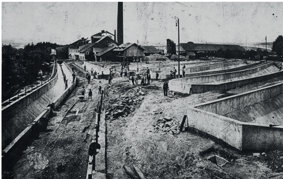
Zborovice, rozšiřování řepných splavů a plavicích kanálů, 1902. Reprofoto Roman Polášek, archiv MCPD
