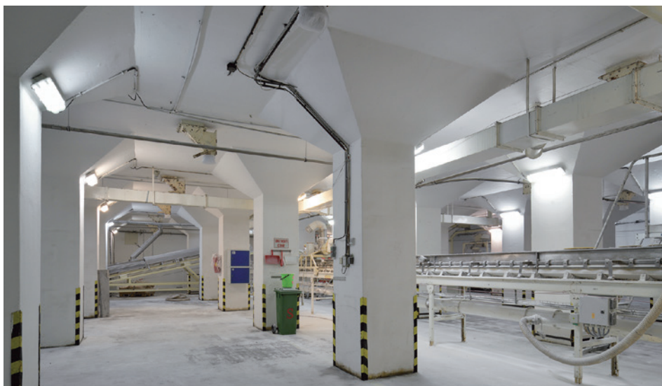
Litovel, silo na cukr, prostor pod zásobníky. Foto Roman Polášek, 2023
