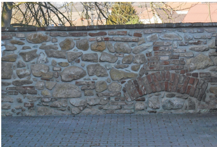
Kostelní Vydří, původní obvodová zeď cukrovaru. Foto Michaela Ryšková, 2024
