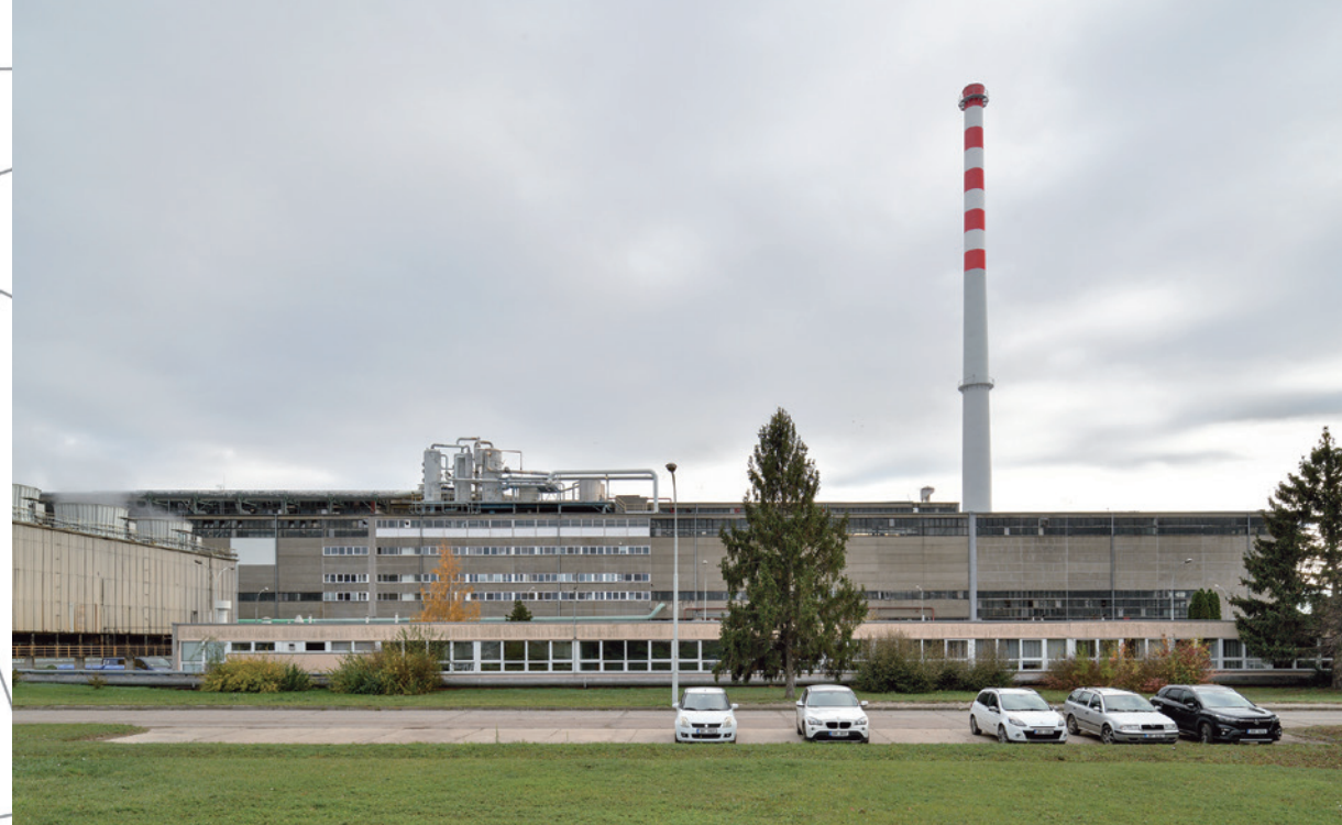
Hrušovany nad Jevišovkou, výrobní a správní budova. Foto Roman Polášek, 2023
