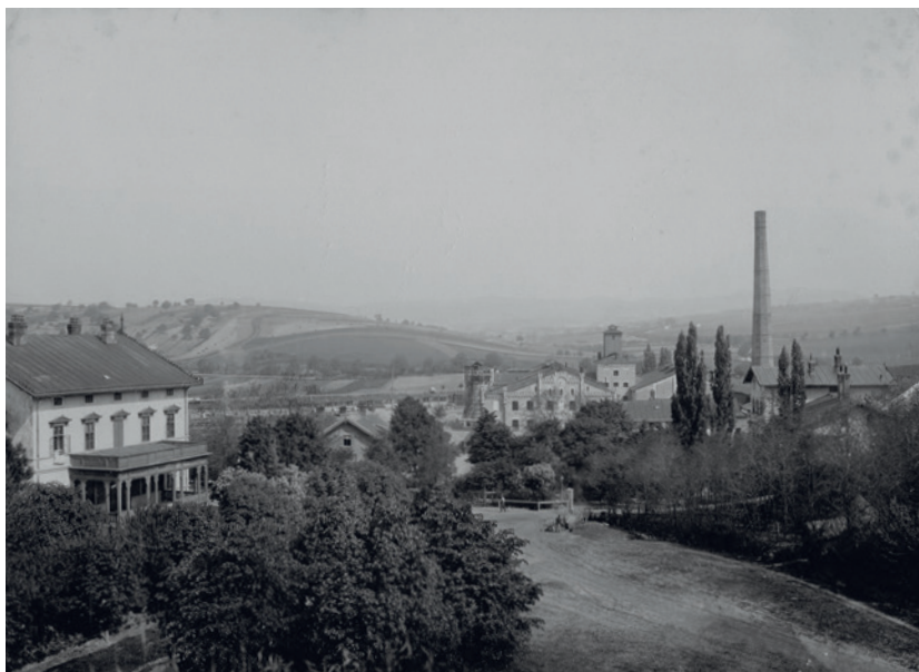
Kelčany, celkový pohled na cukrovar (se skladem cukru v popředí) přes nádvoří s parčíkem, vlevo dům pro hosty, dobová pohlednice. Sbírká Daniela Froňka
