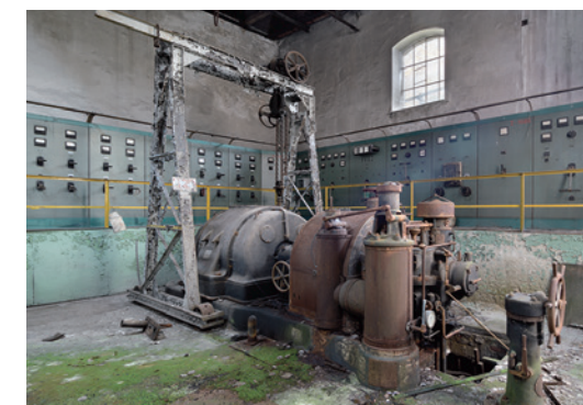
Bedihošť, parní turbosoustroj sestávající z parní turbíny (První brněnská strojírenská společnost, 1915) a elektrického generátoru. Foto Tomáš Flimel, 1989; Roman Polášek, 2023
