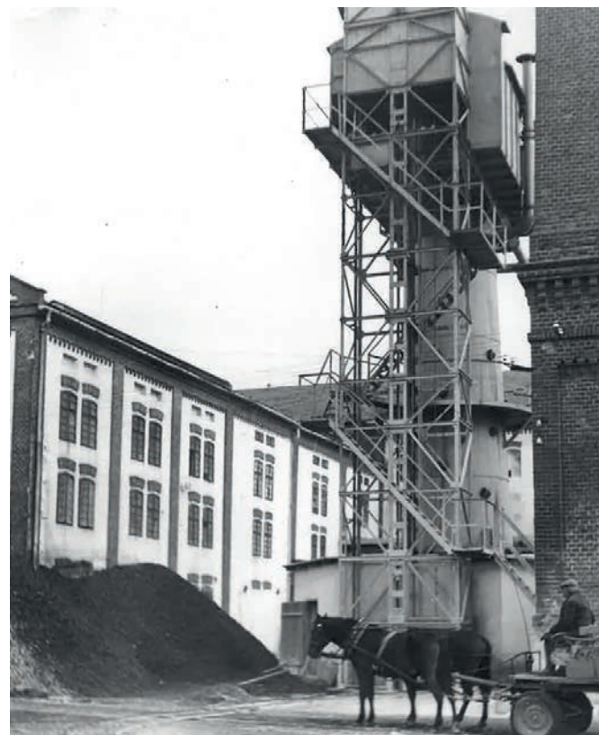
Opava-Vávrovice, starý cukrovar s vápenkou typu Khern, foto z roku 1947. Moravskoslezské cukrovary, závod Opava, fotoarchiv
