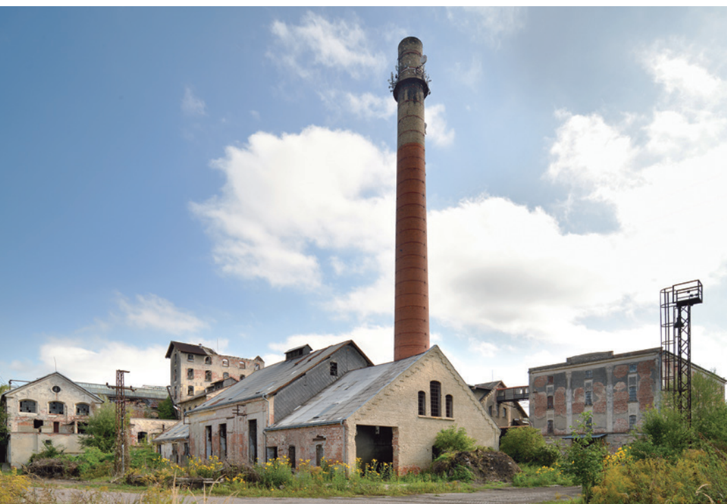
Bedihošť, kotelná a komín, v pozadí filtrační věž. Foto Roman Polášek, 2023
