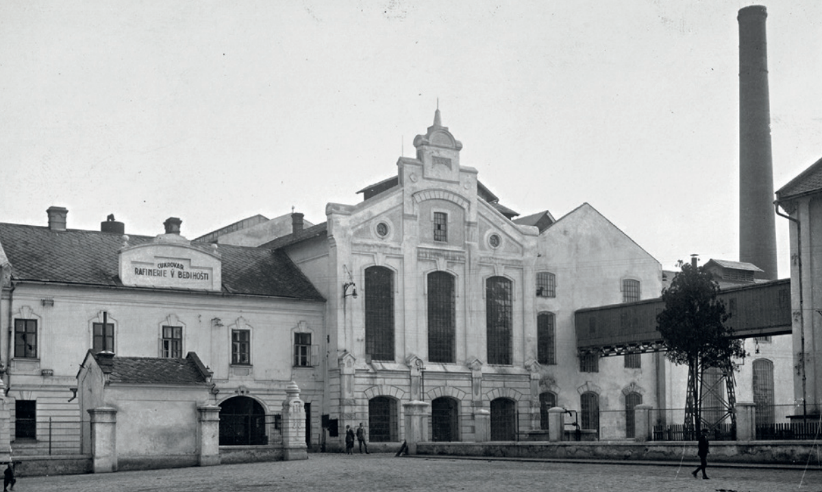
Bedihošť, průčelí cukrovaru se štítem difuzní stanice, stav v roce 1925. SOKA Prostějov, fond MNV Bedihošť, inv. č. 132, obecní kronika
