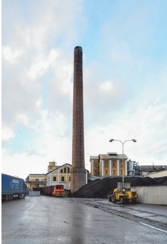
Vrbatky, kotelna, komín a filtrační věž. Foto Roman Polášek, 2023
